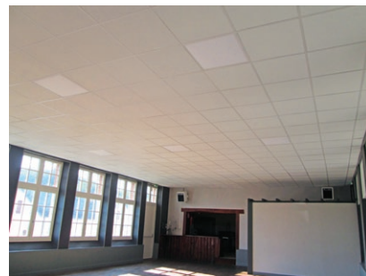
Plafond acoustique Salle des Fêtes 4 600 € HT
